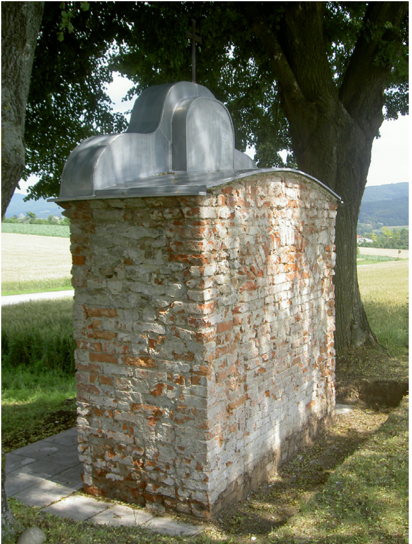
Das Dach wurde neu verkleidet als Schutz vor den Bäumen.
