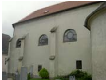
Oben vor und unten nach der Renovierung in Sieghartskirchen.
